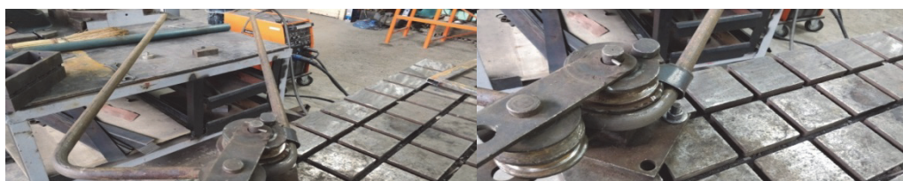
Рисунок 1 – Процесс гибки труб
