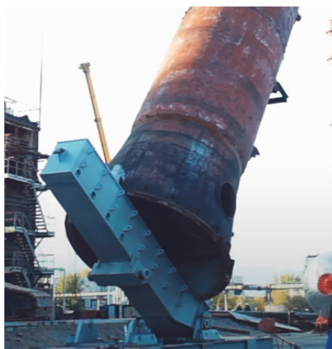
Рисунок 1 – Пример конструкции кантователя
